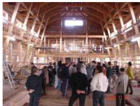
県産材を使用した建築現場の見学会
