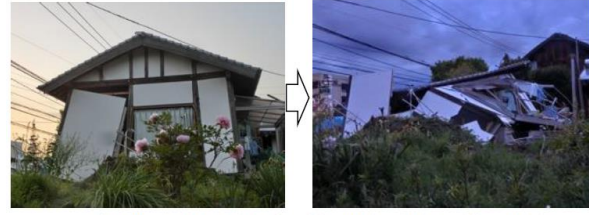
写真 6.2.2 壁を外れただけの家屋(左: 4/15)が倒壊した(右: 4/16)例
