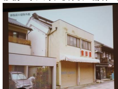
会場で紹介された改修前の状態
