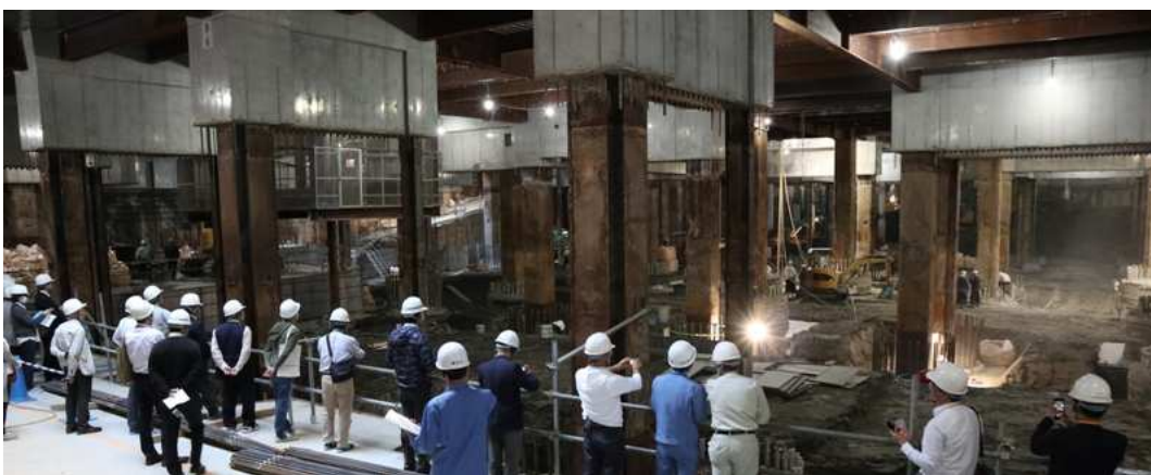
横浜市新市庁舎現場見学会 地下掘削工事の様子
