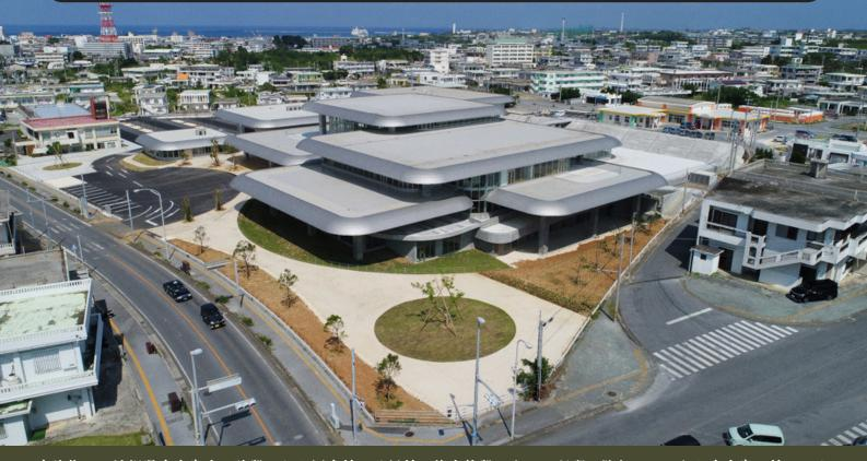
本建物は、沖縄県宮古島市に建設された図書館・公民館の複合施設である。珊瑚が隆起してできた宮古島の持つエネルギーの原点をデザインとしてテーブルサンゴをイメージし、市の新たなシンボルとしての施設を目指して設計した。 市民が憩い集うことのできる半屋外空間は、プレキャスト・プレストレストコンクリート+鉄骨による約6mの片持ち梁によって大きな庇を計画した。宮古島の強い日射を避け、風が通り抜ける日陰の元、
