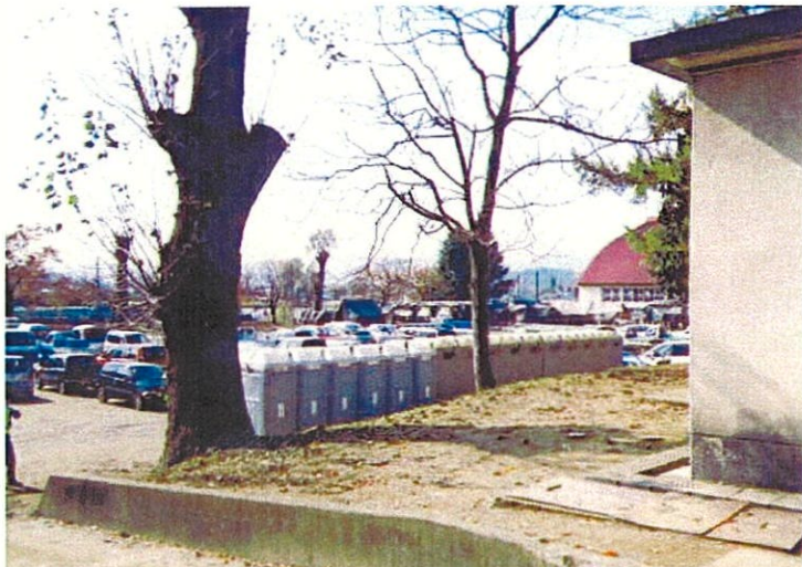
避難所の仮設トイレ
