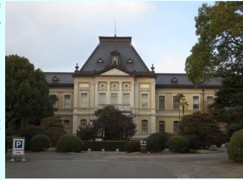
重文・京都府旧本館（明治37年）
