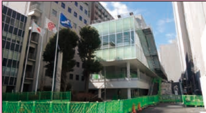
【エネセン棟 外観】
