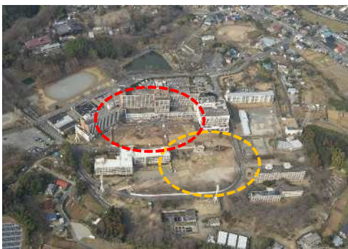
【着工前(平成25年3月)】
