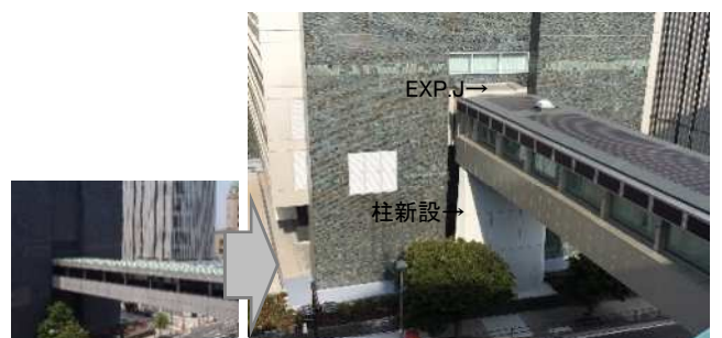
【本庁舎側跨道橋】
