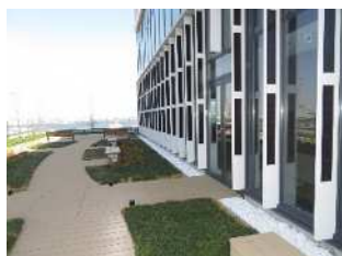
【11 階屋上庭園 薄膜太陽電池組み込みのルーバー】
