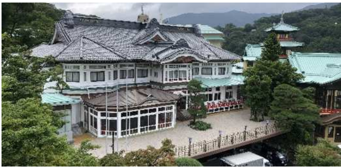
■改修後の本館（右手の建築物が食堂棟であるが、両建築物は地下で接続されているため法の適用上は一棟扱い）
