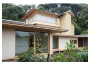
【④南側 エレベーター棟】
