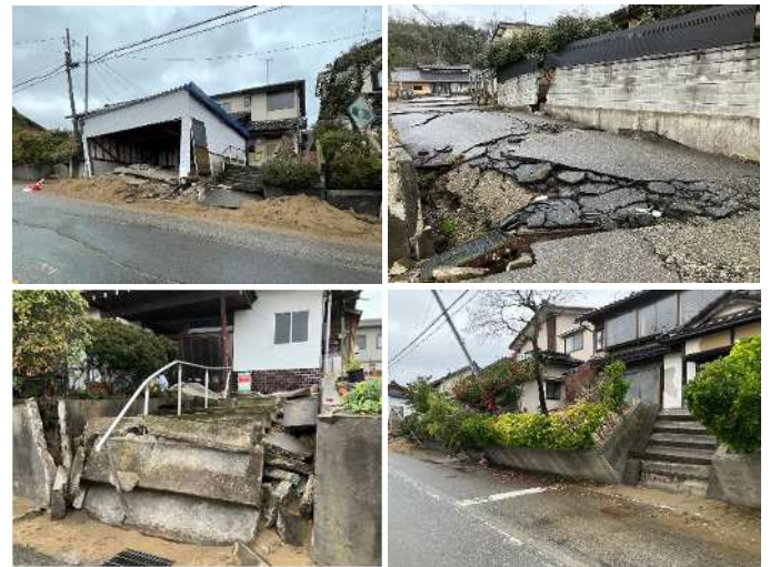
【内灘町で液状化の被害が大きい地域の状況】
