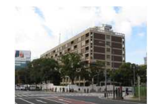
【横浜市役所行政棟】工事中
