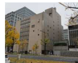
【東京銀行大阪支店】解体
