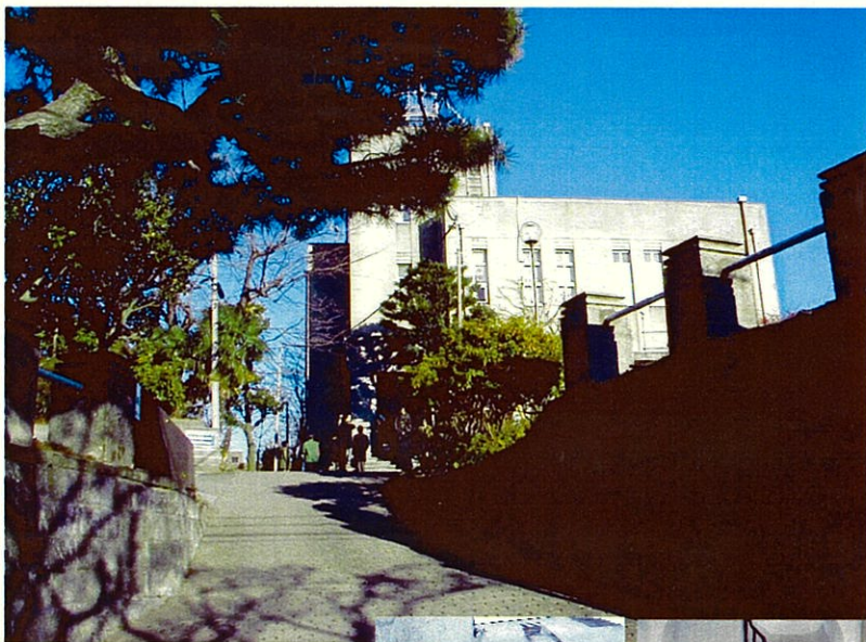
「横浜地方気象台」 上 (外観) 右 (レリーフ、階段室)
